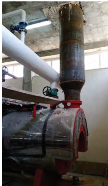
دودکش فلزی دیگ فولادی
